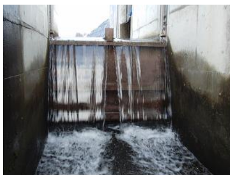
図1 既設の水門における水膜振動
