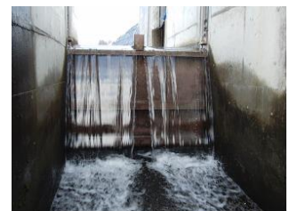
図1 水門における水膜振動
