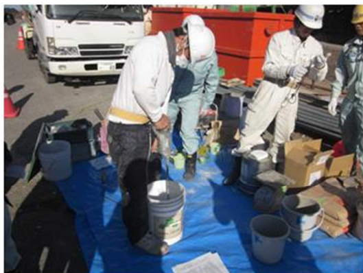
(a) 補修用モルタル練り状況
