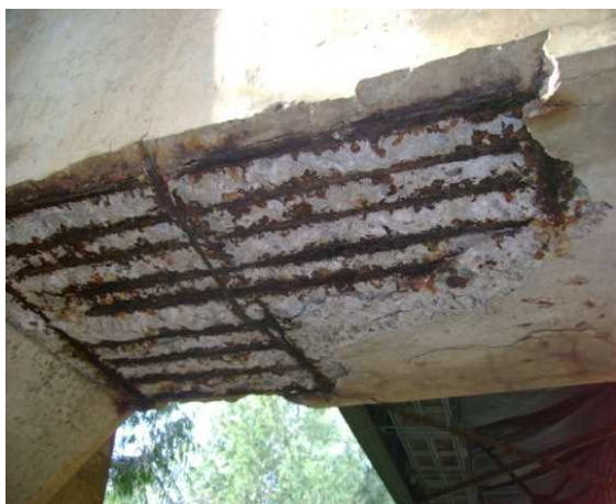
(a) 橋梁上部構造での事例
