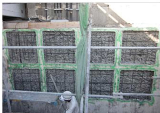
写真-5 はつり工の完了
