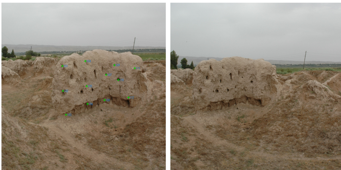
図 3-3 壁-A の立体写真。左写真には標定点+を示している。
