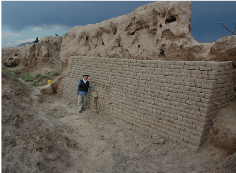
図 3-18 壁-B の修復施工中の写真
