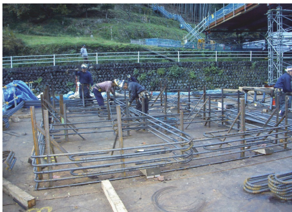
写真 6.3.3 帯鉄筋のプレファブ化作業状況
