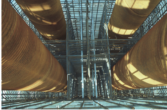
断面内の鋼材配置状況
