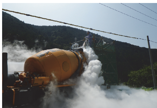
写真 6.4.3 液体窒素噴射状況
