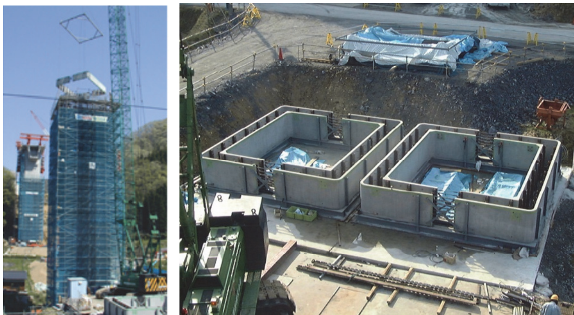
写真7.1.1 RC橋脚のハーフプレキャスト化
