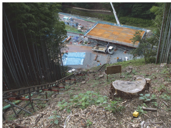
写真 6.3.5 モノレールによるケーブルクレーン用資材搬入
