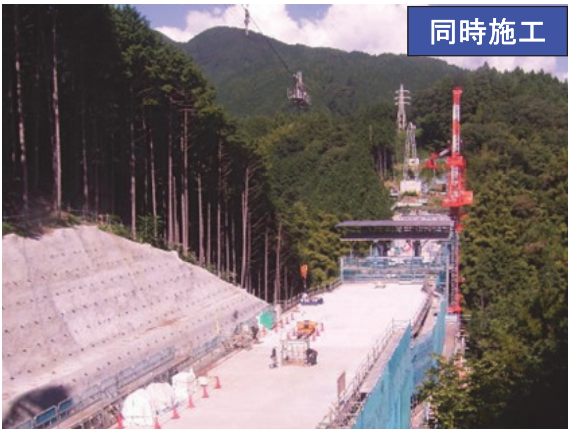
写真 6.3.6 ケーブルクレーン施工状況
