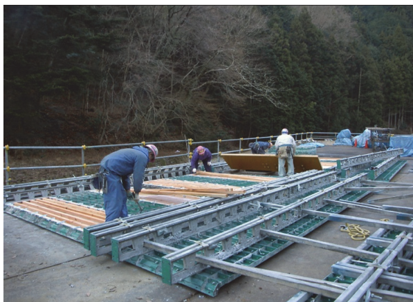
写真 6.3.4 大判型枠作業状況
