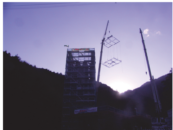
写真 6.3.3 帯鉄筋のプレファブ化作業状況
