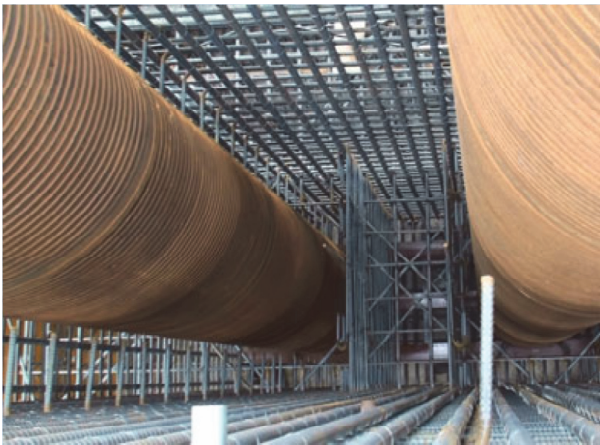
写真 6.2.3 鋼管建て込み状況
