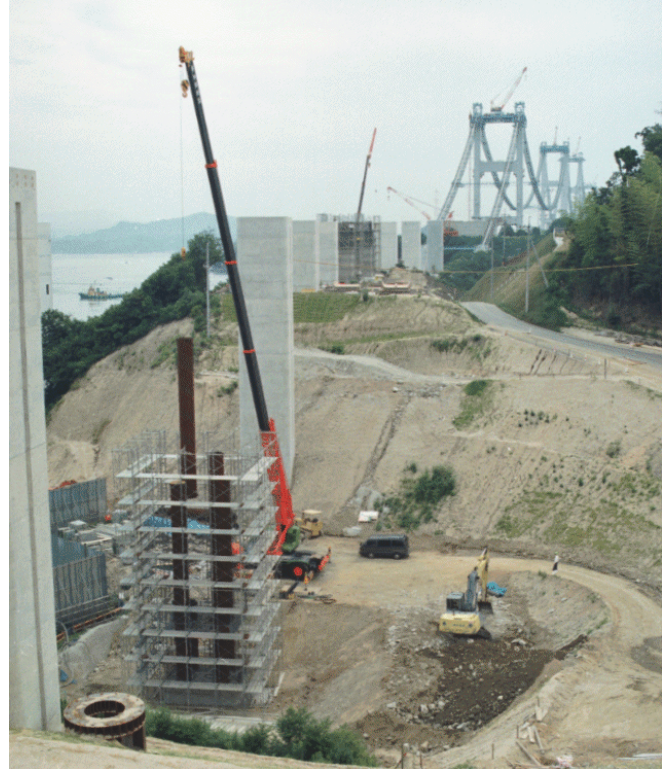
写真 6.2.1 下田水高架橋鋼管建て込み状況
