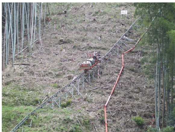
写真 6.3.5 モノレールによるケーブルクレーン用資材搬入
