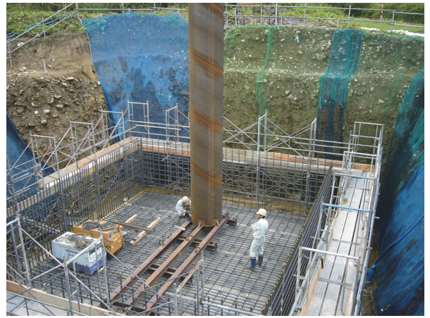
写真 6.2.2 鋼管架台設置状況
