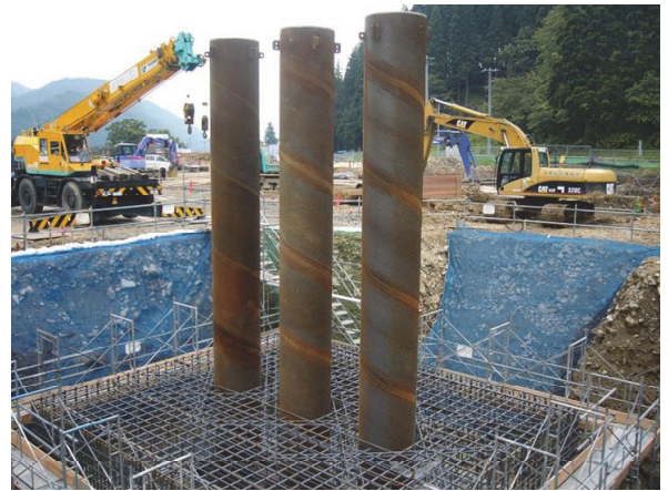
写真 6.2.3 鋼管建て込み状況
