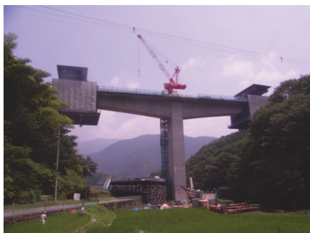
写真 6.3.1 上部工片持架設状況
