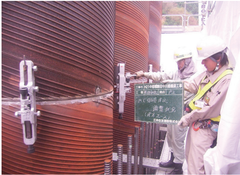
写真 6.3.2 専用治具を用いた鋼管接合
