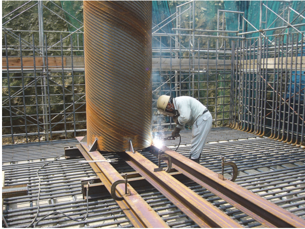
写真 6.2.2 鋼管架台設置状況
