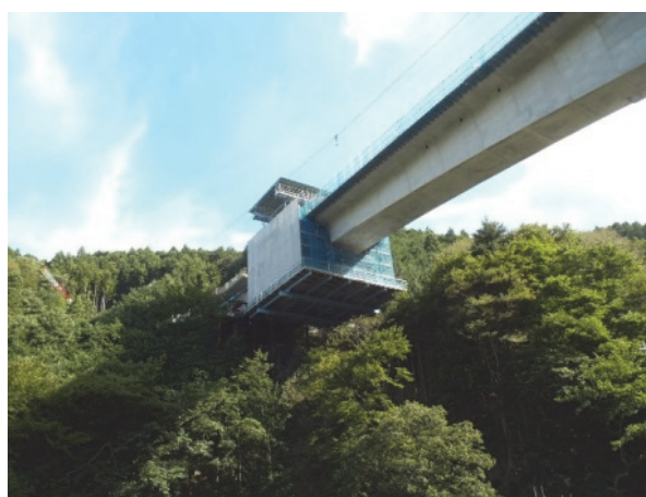
写真 6.3.1 上部工片持架設状況
