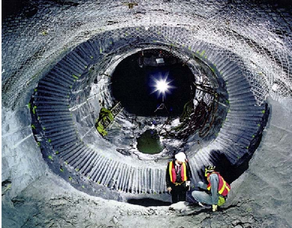
図 3.2.4 粘土プラグ拡幅部施工後の岩盤状況
