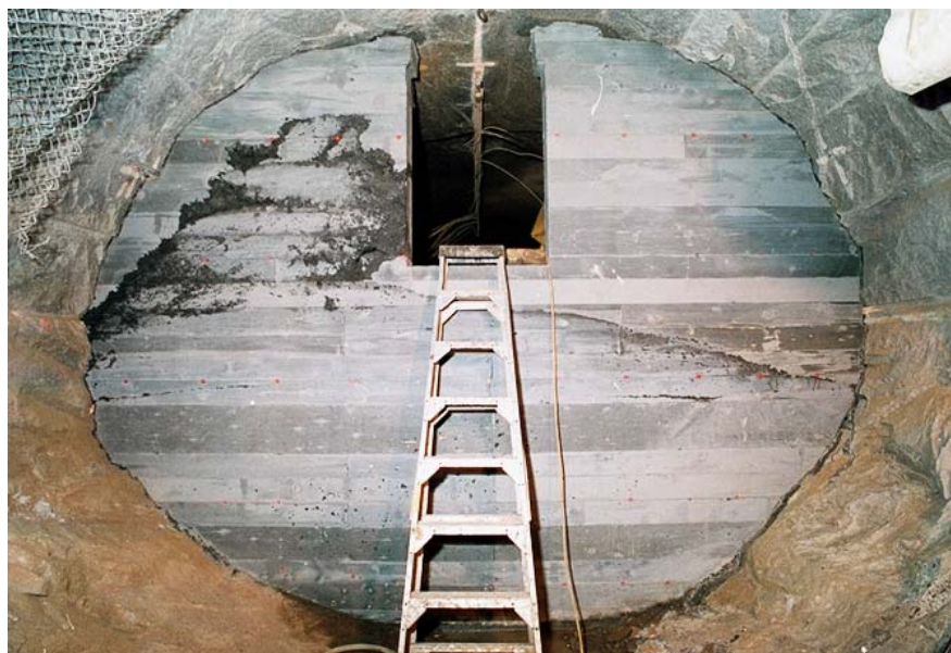
図3.2.8 コンクリートプラグ完成状況
