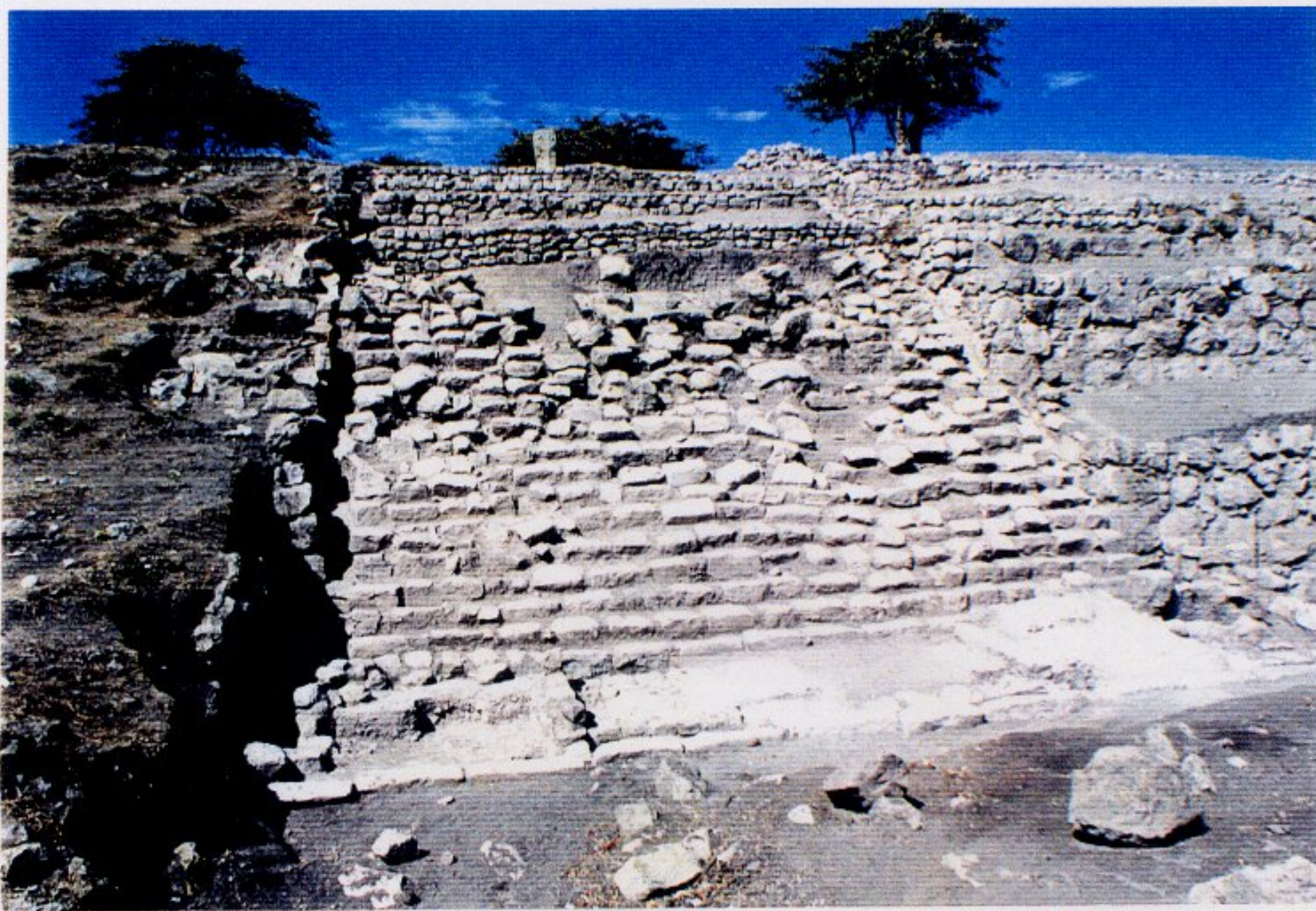
b. Vista de la Escalera Principal.
