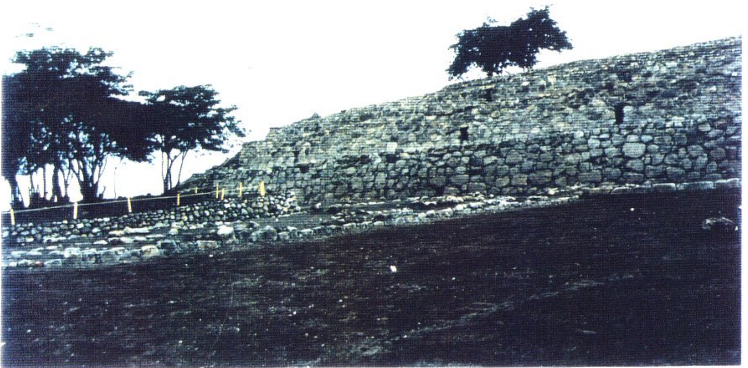
FOTO 12. Después de la intervención; Sector R, Parte Este de la Fachada Frontal (Oct, 2002)
