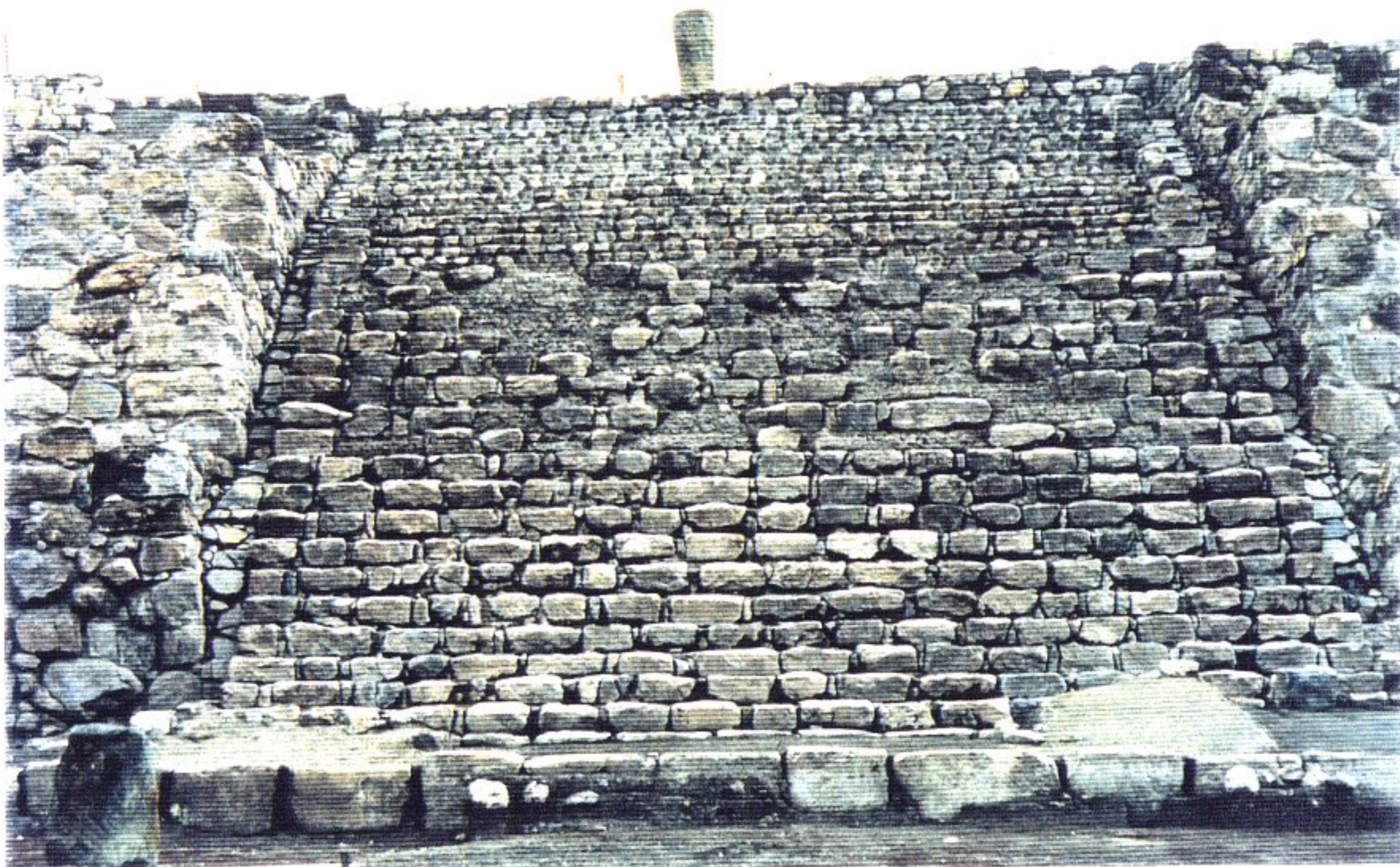
FOTO 13. Después de la intervención; Escalera Principal de la Fachada Frontal (Oct, 2002)
