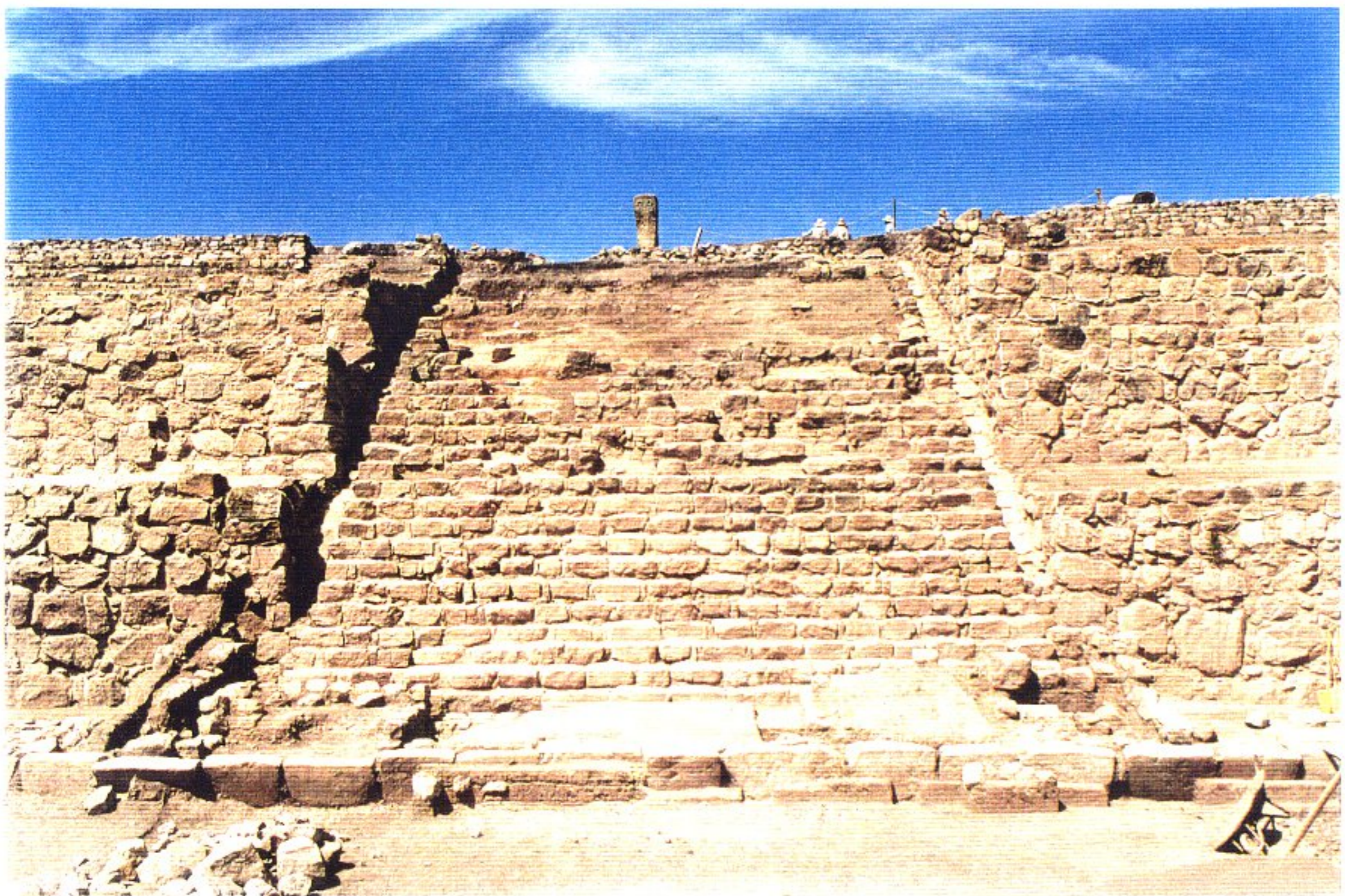
FOTO 8. Durante la intervención; Escalera Principal de la Fachada Frontal (Ago, 2002)
