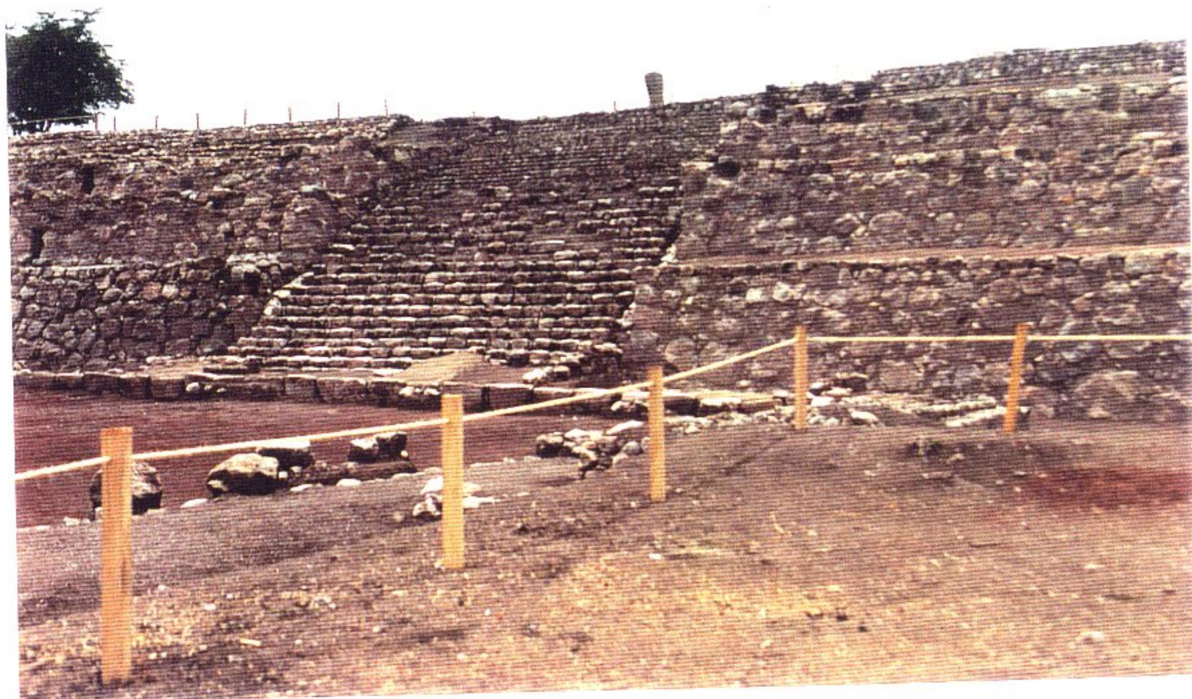
FOTO 21. Preservación de la Fachada Frontal (Oct, 2002)
