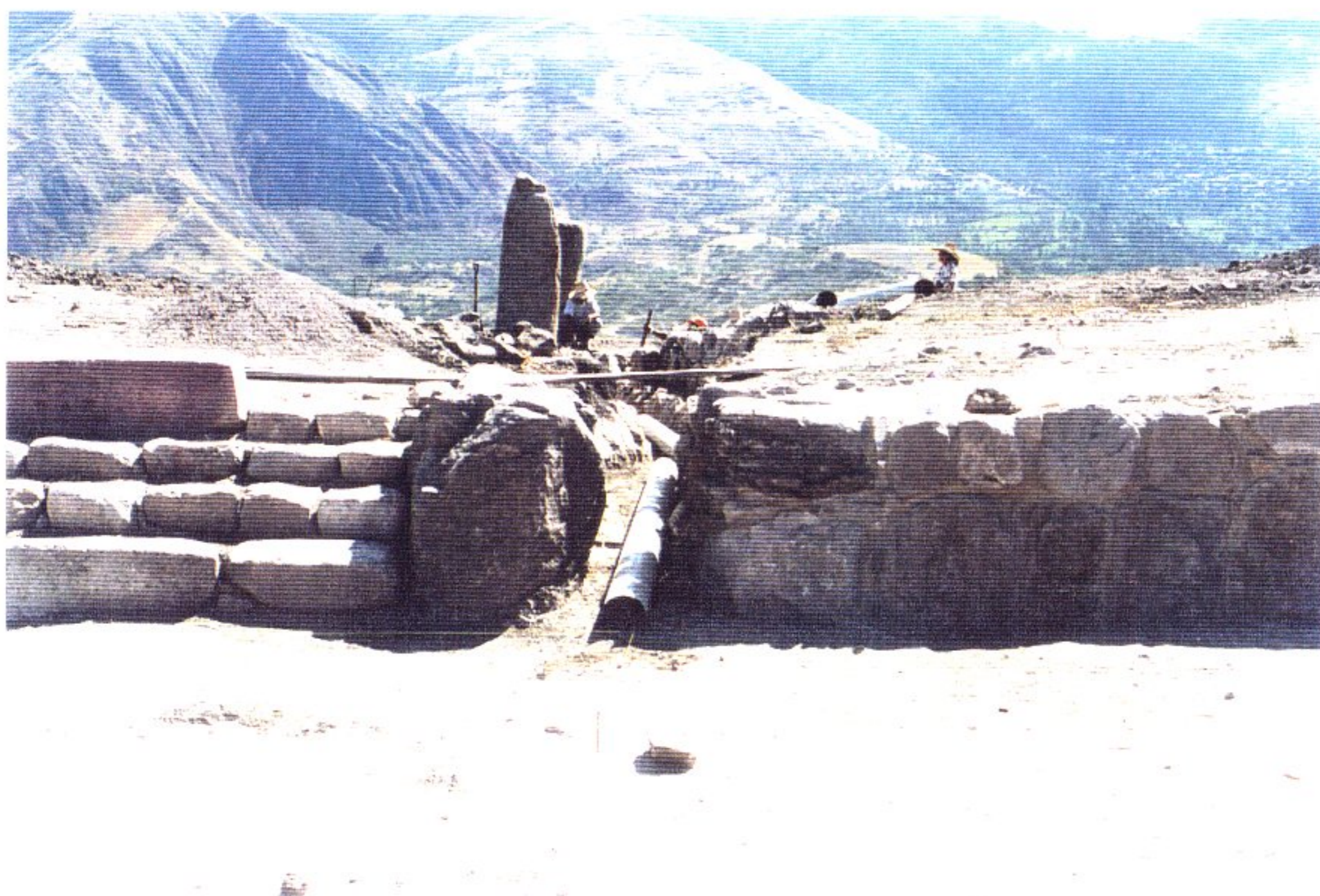
FOTO 18. Canal de drenaje desde la Plaza Central hasta la Fachada Frontal (Oct, 2002)
