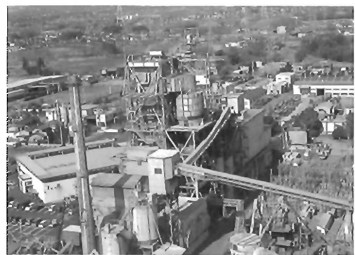
自家発電設備
