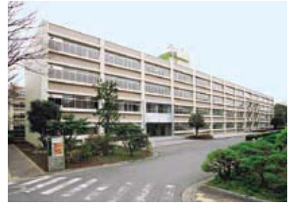
A・B棟改修竣工写真
