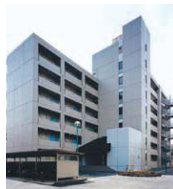
国際交流会館（3号館）
