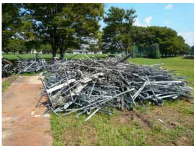
改修工事廃材の分別収集再資源化
