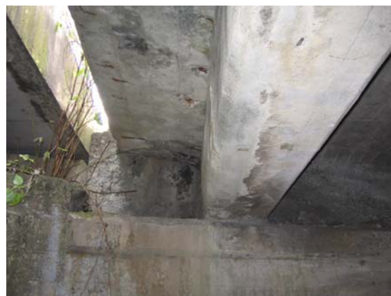
写真-1 張出し床版と主桁の状態 (A 橋)
