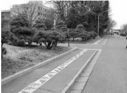
図8 埼玉大学内に敷設したCamNavi用点字ブロック
