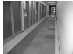
図13 実験で敷設したタイルカーペット
