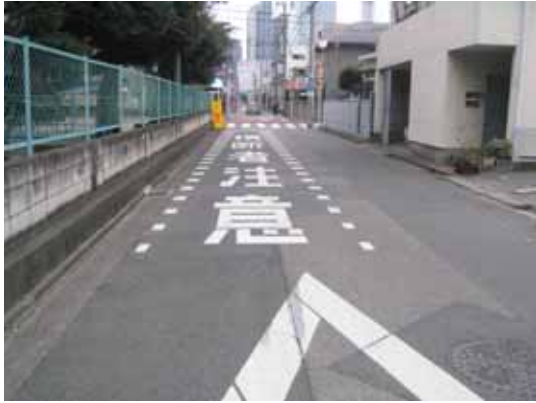
写真 3-6 生活道路の安全対策として実施された路面表示
