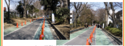
写真1 両側が歩行者空間(左写真)
