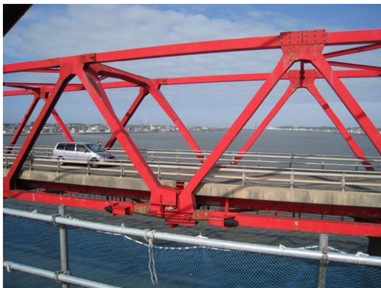
図 9.1 銚子大橋（ゲルバートラス橋）の掛け違い部
