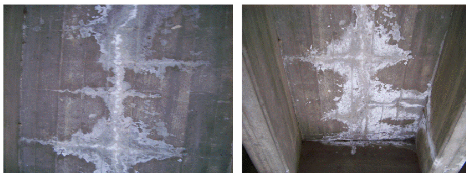
図1 ペディストリアンデッキにおける塩類析出(撮影時期:9月(左側)および2月(右側))
