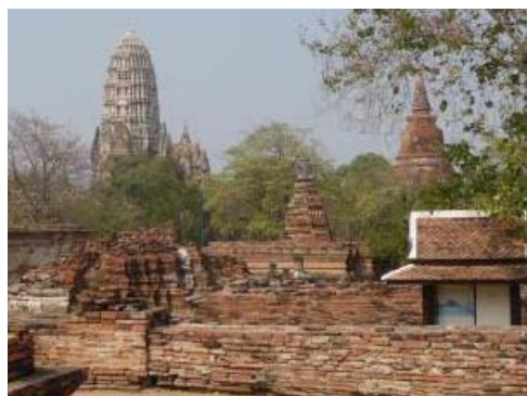
図4 アユタヤ遺跡のレンガ壁の劣化状況
