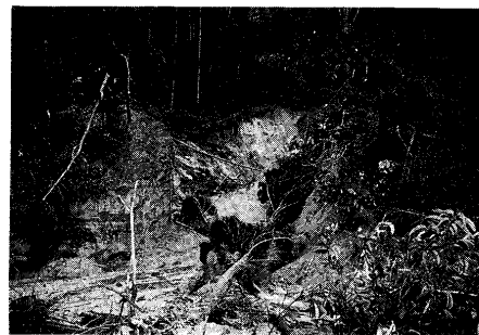
写真一 1 大信中学校裏の切土法面崩壊箇所
