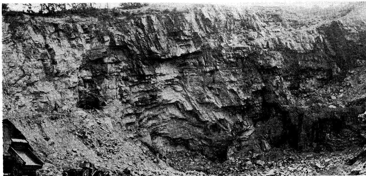
写真-1 花コウ岩の露頭 シールディングジョイント他2系列の分離面が顕著、高さ約60m、愛媛県大島荒々鼻
