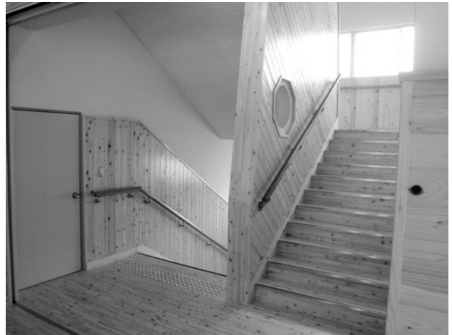
図4. 木質化後の階段付近
