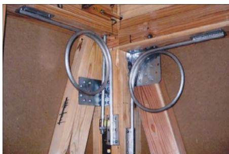
図15 木造住宅に取り付けたねじりばね
