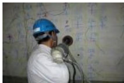
写真1 穿孔作業時の振動計測
