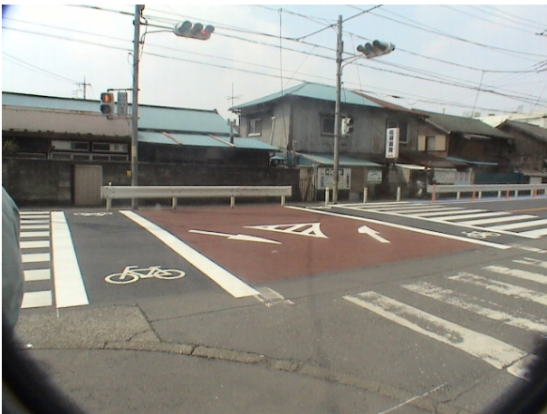
Photo 5 対策実施後の様子 (交差点内のベンガラ舗装)
