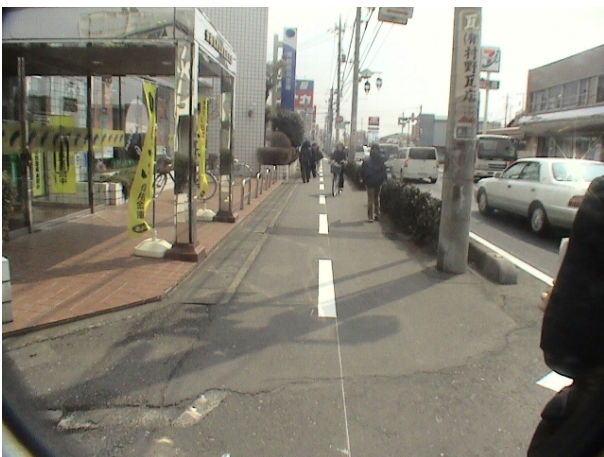
Photo 6 対策実施後の様子 (北側歩道内の歩行者・自転車の通行帯の設置)
