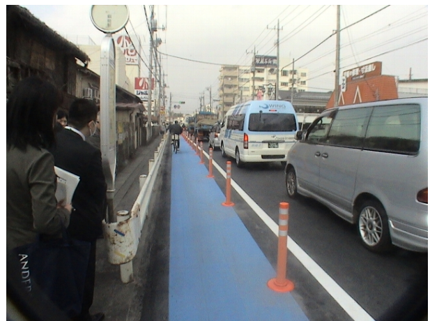
Photo 3 対策実施後の様子 (南側車道の自転車通行帯)
