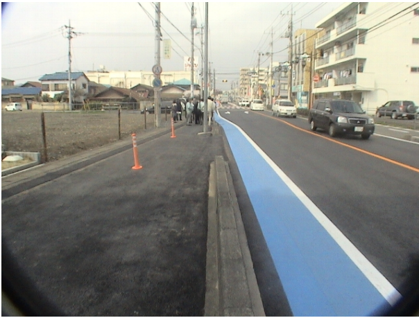
Photo 4 対策実施後の様子 (南側車道の自転車通行帯及び路面の修繕)
