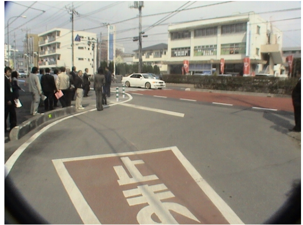
Photo 7 対策実施後の様子 (ポストコーンでY字路をなるべく直角に接続させる)
