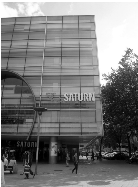
ドイツ、ハンブルグの駅前（シティ・センター）にある地下1階地上5階建て、18,000 m 2 を擁する店舗（2010年8月撮影）
