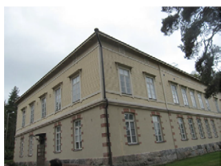
図23 学校校舎近景
