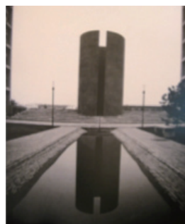
《SOHO “Concrete” (現代城のランドスケープ)》
