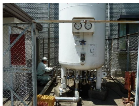
Cold Evaporator 定期メンテナンス
