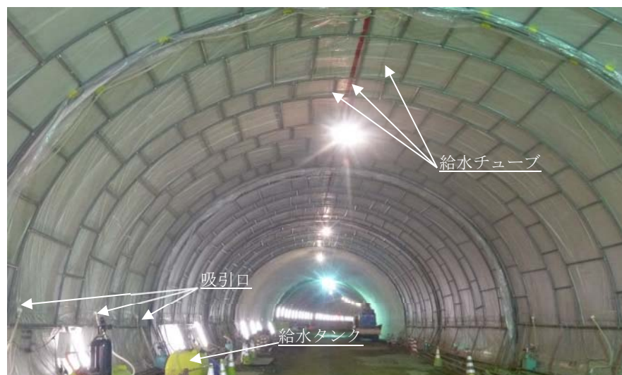
写真-4.3 シート吸引方式給水養生工法適用
