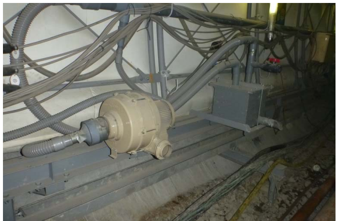
写真-3.12 吸引ファンおよび除水除塵機
