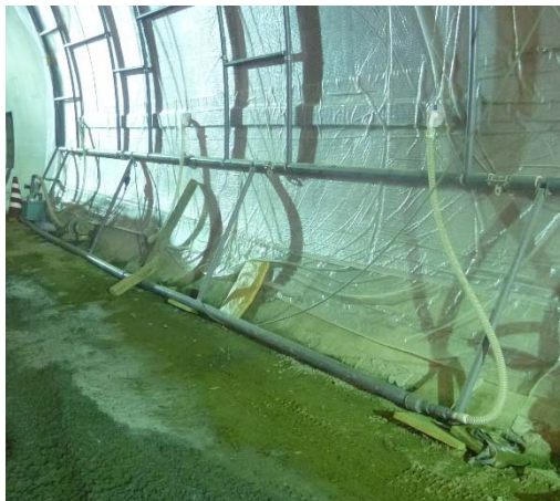
写真-3.15 吸引、給水設備
