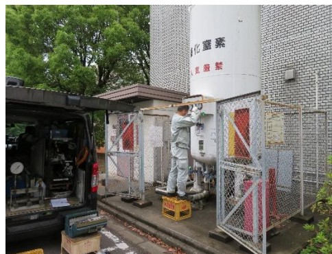
Cold Evaporator 定期メンテナンス
