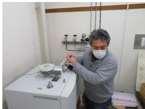
集中配管修理 元素分析室
