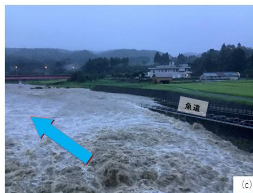
図 2-3 (a)2011 年から 2021 年の 11 年間に発生した洪水（青： 1,500\text{m}^3/\text{s} 以上、橙： 3,000\text{m}^3/\text{s} 以上）。(b)洪水後の魚道の土砂堆積状況。(c)洪水時（約 4,500\text{m}^3/\text{s} ）の状況。
