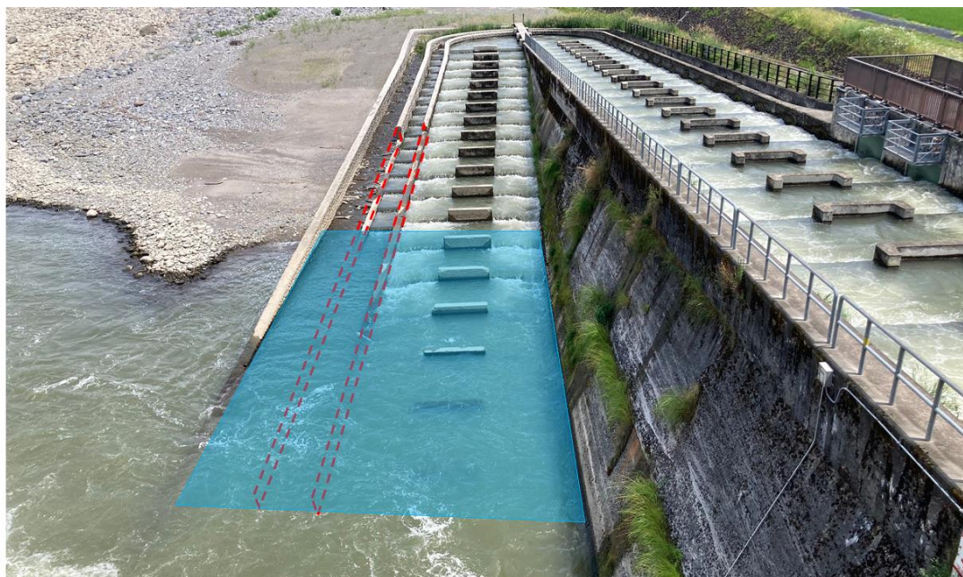
図 2-8 魚道入口部の赤い破線部分の壁を撤去した状況。
