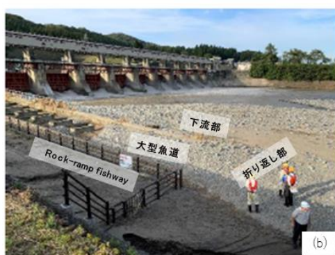
図 2-3 (a)2011 年から 2021 年の 11 年間に発生した洪水（青： 1,500\text{m}^3/\text{s} 以上、橙： 3,000\text{m}^3/\text{s} 以上）。(b)洪水後の魚道の土砂堆積状況。(c)洪水時（約 4,500\text{m}^3/\text{s} ）の状況。
