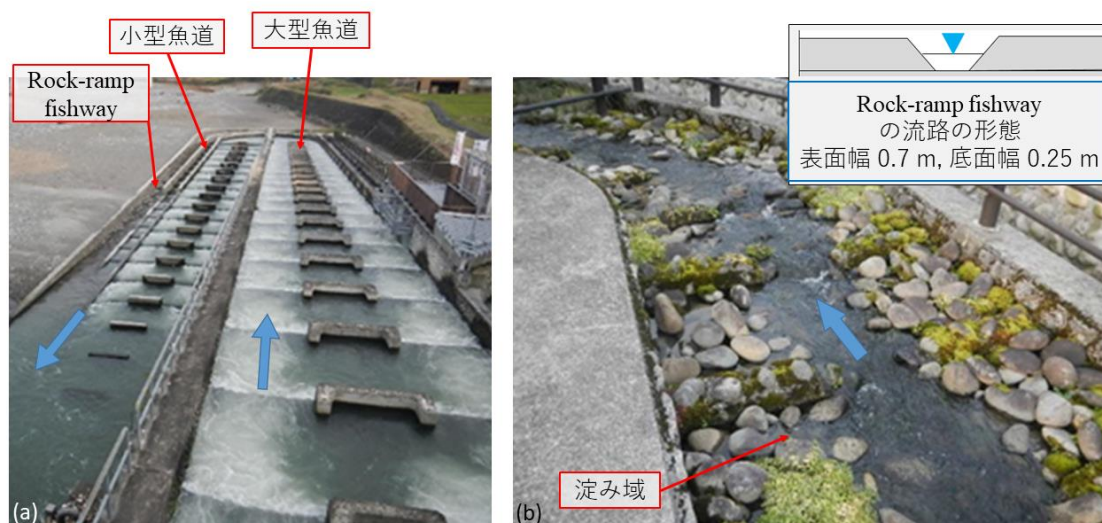
図 2-7 (a) 3つの魚道を上流側から望む。(b) Rock-ramp fishway の流路の形態と淀み域。
